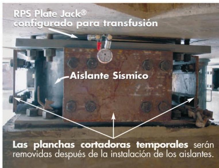
**295 gatos Plate Jacks®** son usados para transferir el peso del edificio a aislantes sísmicos y a vigas móviles en este proyecto del Capitolio del Estado de Utah.
